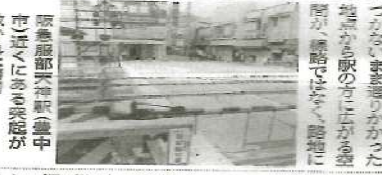
事故現場近くの踏切
